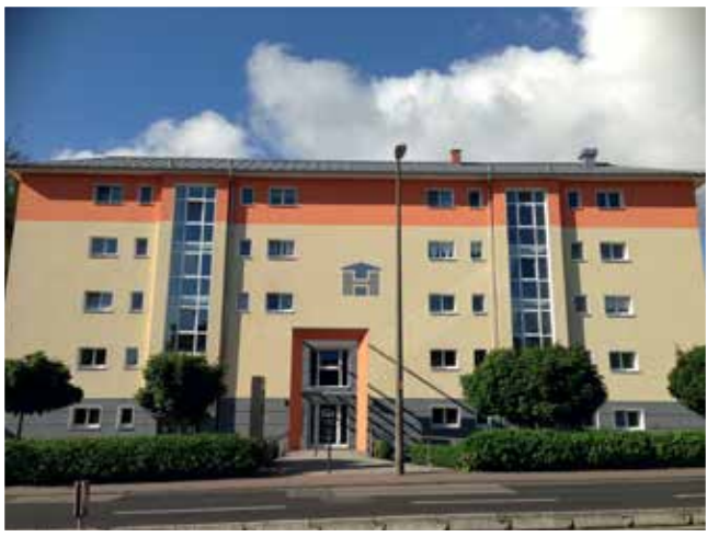
Büro- und Wohnhaus Hessenring 92-94, Bad Homburg
