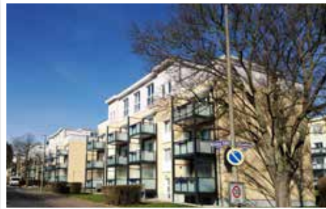
Wohnquartier „Kronberger Carrée mit Penthauswohnungen, Wiesbadener Str., Bad Homburg
