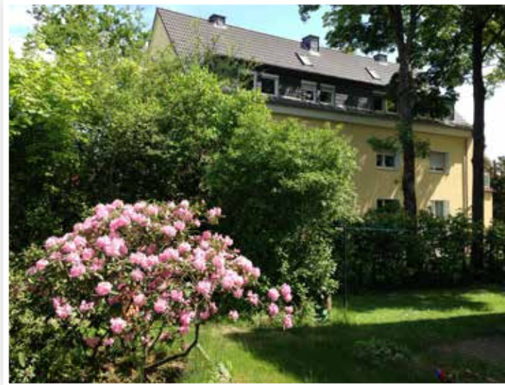
Wohnanlage Dielmannstr., Kronberg
