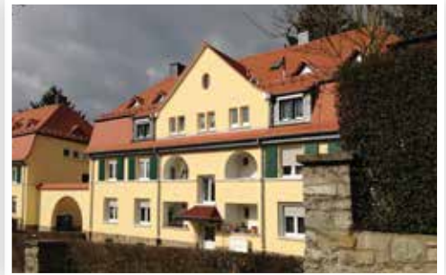
Sanierung Kronberger Str. 3+5, Bad Homburg
