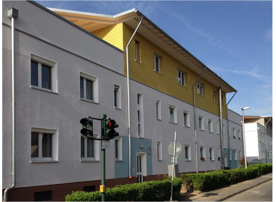
Neubau Dachgeschosswohnungen Feldstr., Bad Homburg
