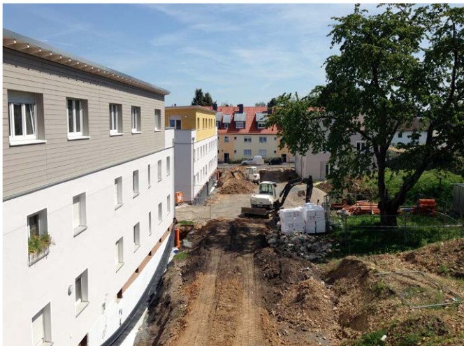
Neubau Dachgeschosswohnungen Feldstr., Bad Homburg
