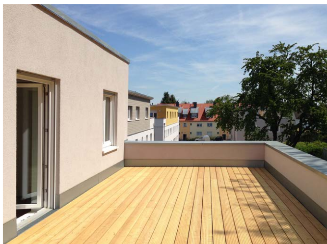
Neubau Feldstr., Bad Homburg
