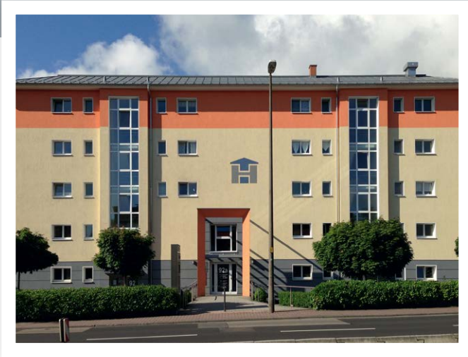
Büro- und Wohnhaus Hessenring 92-94, Bad Homburg
