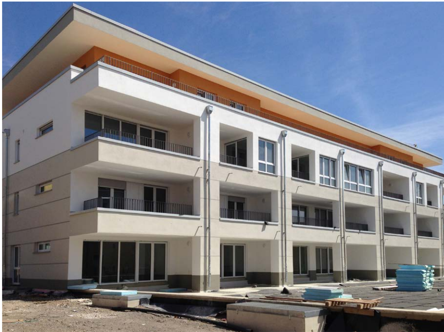
Neubau Kronberger Carrée, Bad Homburg, Wiesbadener Str. 2 a-f
