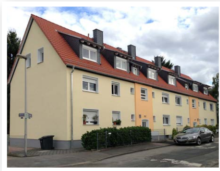
Bad Homburg, Zum Dornbach 5 +7: Sanierung Altbestand und Bau von 2 Dachgeschosswohnungen
