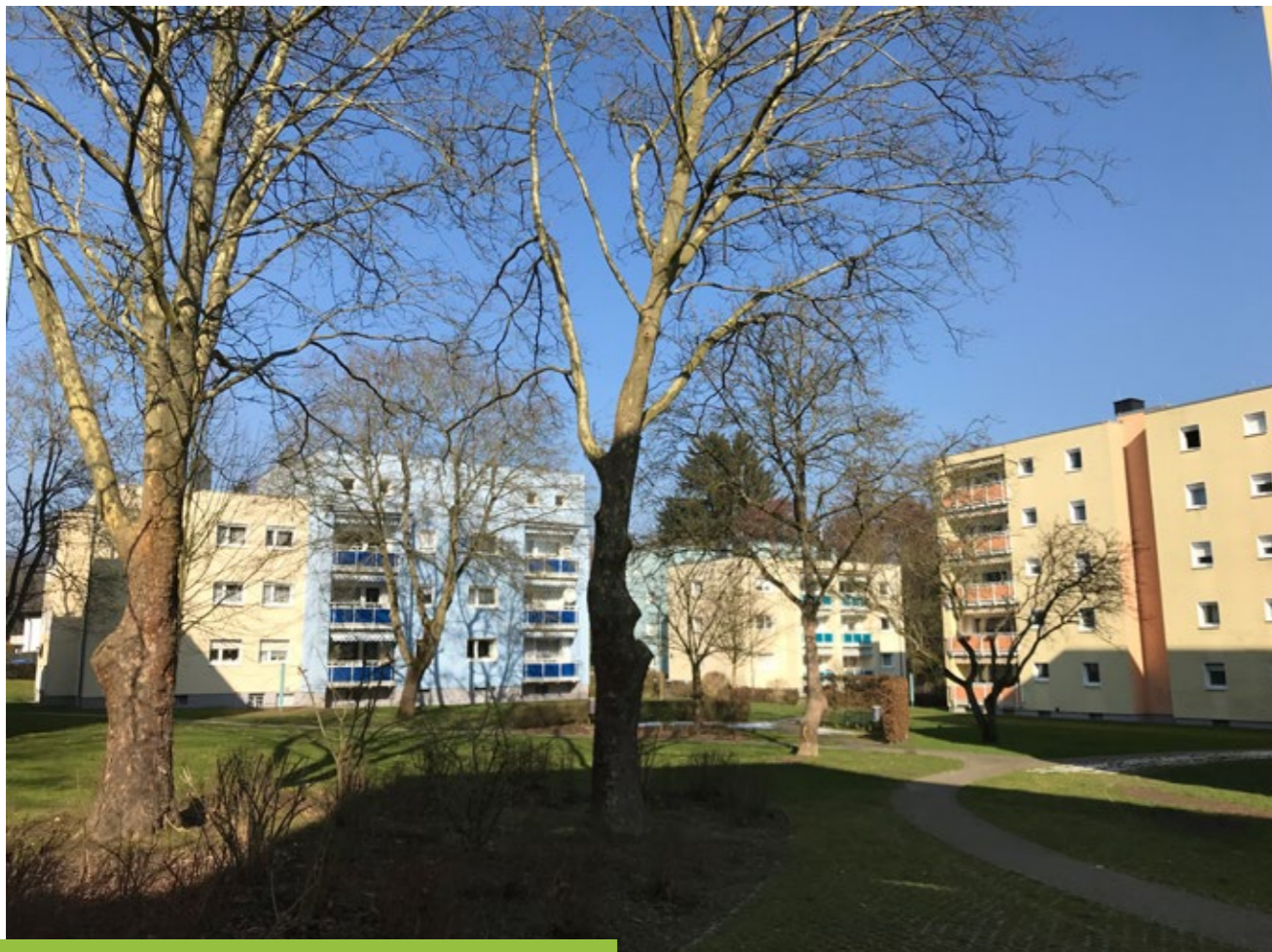
Wohnanlage Hofheimer Strae (118 Wohnungen), Bad Homburg
