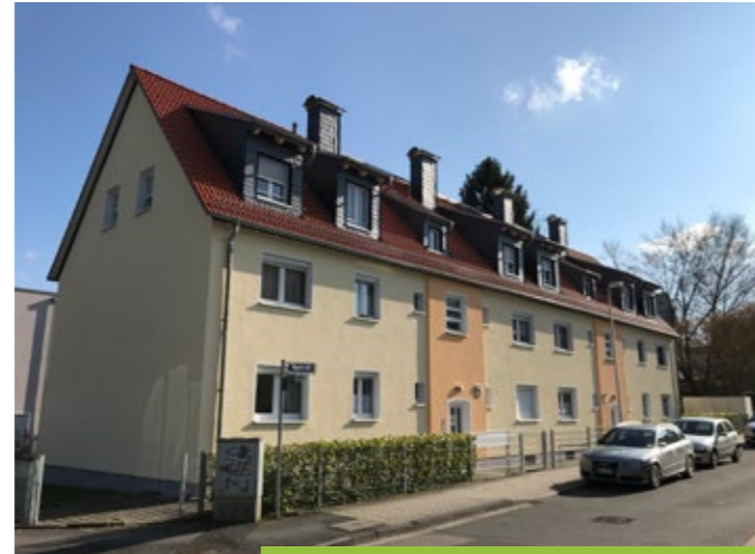
Hugelstrae 1+3, Bad Homburg Neuausbau von zwei Dachgeschosswohnungen
