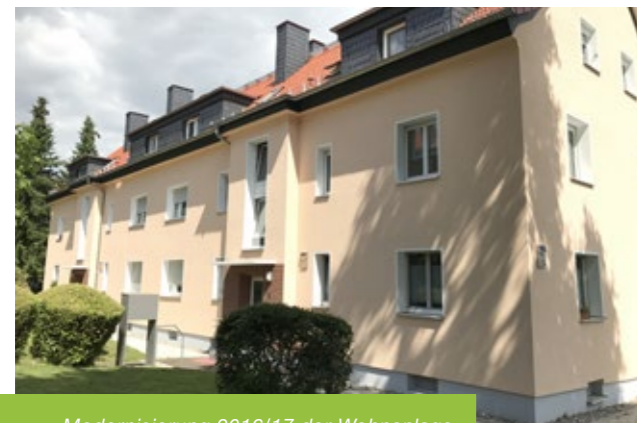
Modernisierung 2016/17 der Wohnanlage Dielmann-, Burnitz- und Schreyer Str. in Kronberg/Ts. (73 Wohnungen)
