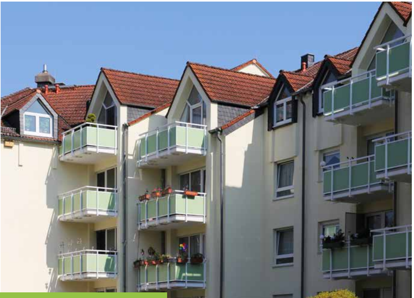
...und sanierte Balkone im Gluckensteinweg 111-115
