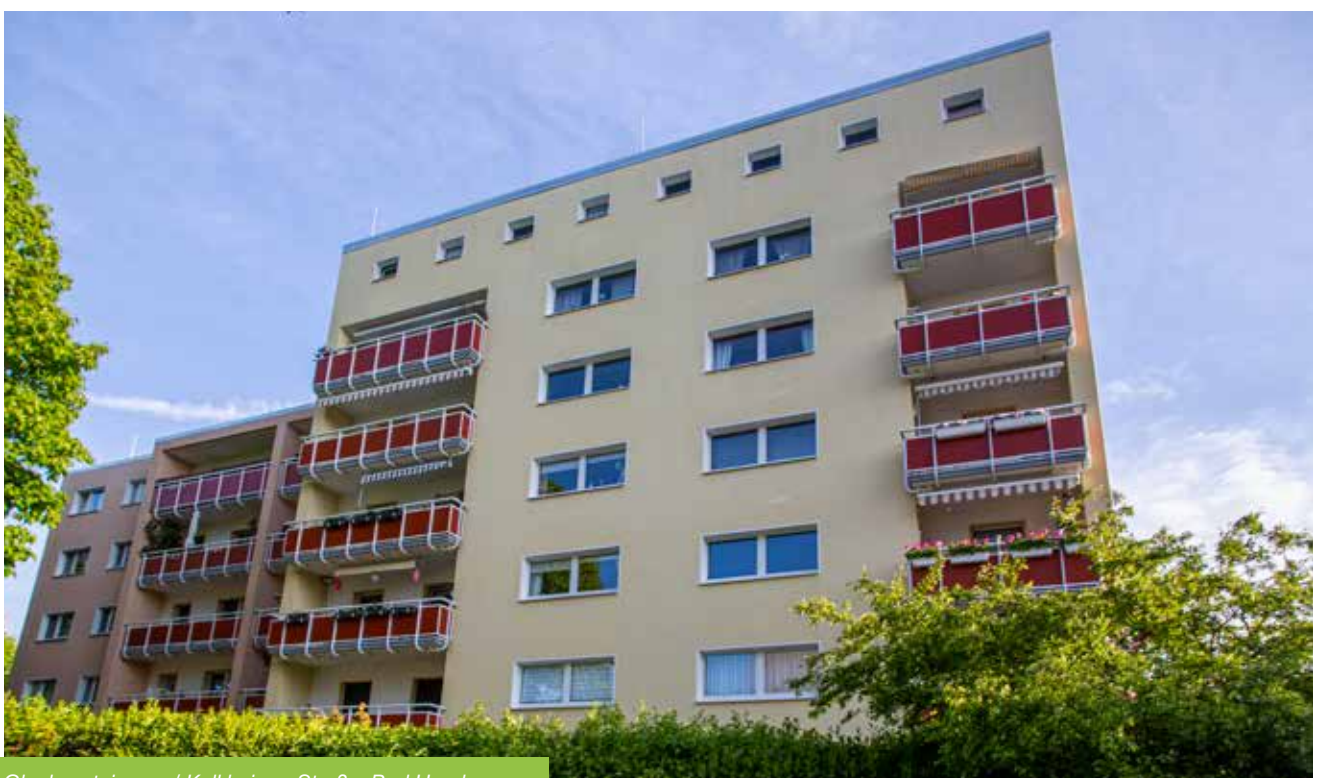
Gluckensteinweg / Kelkheimer Straße, Bad Homburg
