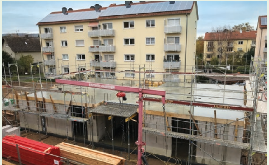
Nordhaus: Der Rohbau des EG steht schon
